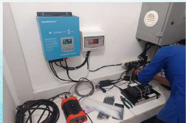
Gambar 1. Pemasangan SCC Hybrid
